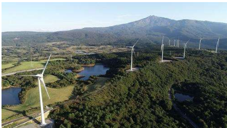
プロジェクト例-2 WE-02 にかほ第二風力発電所(秋田県 41.4MW 2.3MW×18基)
