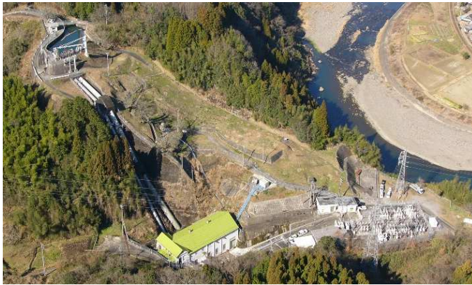
写真-2 水力発電事業 軸丸発電所 * 更新工事前
