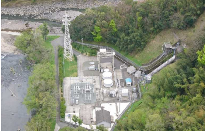
写真-1 水力発電事業 新竹田発電所 * 新設(再開発)工事前
