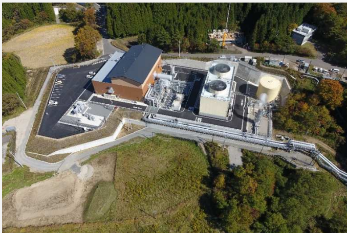
写真-3 地熱発電事業 大岳発電所 * 更新工事後
